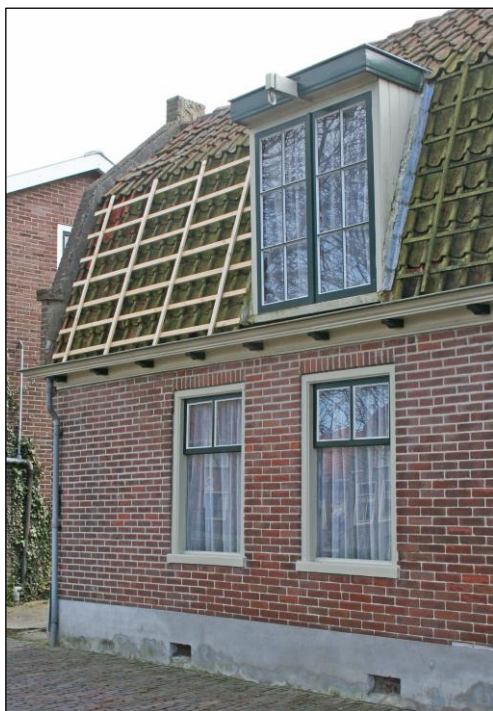
Pannenroosters, ook wel stormroosters genoemd. Veel toegepast langs de kust in West-Nederland om het afwaaien van dakpannen te voorkomen.
