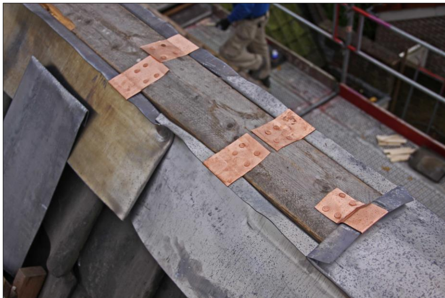
Noklood aangebracht in 3 delen van 25 \text{ kg/m}^2 , vastgezet met koperen klangen. De delen zijn in lengtes van 1,0 meter verschervend aan elkaar gefelst.
