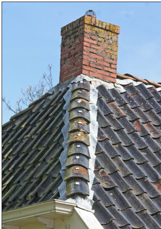
Karakteristieke afwerking van nokken en kepers in Noord-Nederland met loodstroken onder de vorst- en keperpannen.
